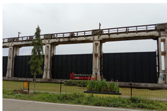
Gambar 3 Cagar Budaya Bendungan Lama Pamarayan
