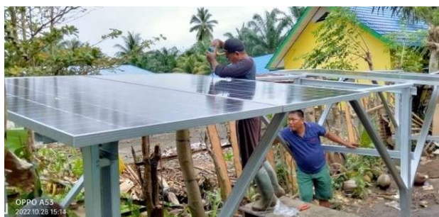
Gambar 6. Poses assembling sel surya sebagai pembangkit listrik tenaga surya
