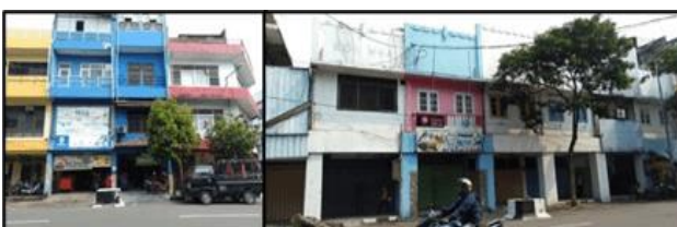
Gambar 6. Kondisi Fasad Bangunan yang Kurang Terkonsep
