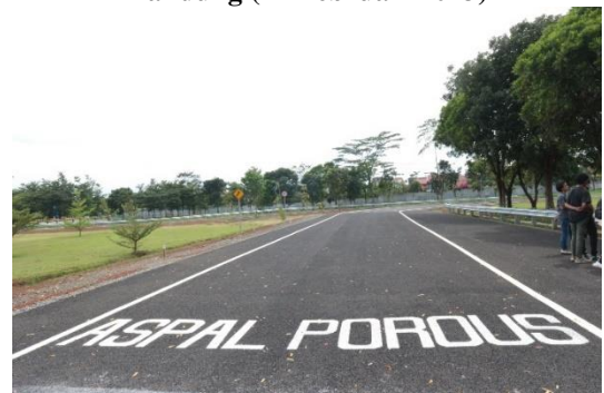
Gambar 8. Hasil trial mix perkerasan aspal pori pada Bina Teknik Jalan dan Jembatan PUPR di Bandung (14 Februari 2023)
