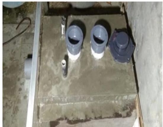
**Gambar 128. Pemasangan pompa hidram pada pondasi**
